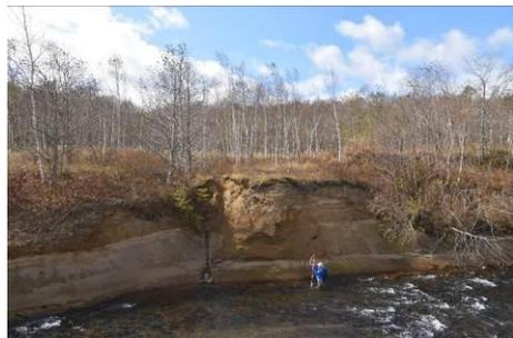
徒歩で 200m 程下流に移動し、川幅を広げた、帯工施工区間を見学し、流れが緩やかとなり河床材が上流域と同様に堆積し、中洲が形成されている。また、河床から河畔林の根元まで測高ポールにより高さを計測し、浸食が 5m 程度であることを目視で確認した。
