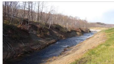
久著呂川の自然再生事業地において、土砂流入対策未施工箇所を見学し、V 字に河床が掘り下げられ、河床材が全て流されていることを確認した。
