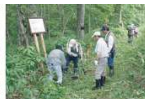
(遊歩道の整備)
